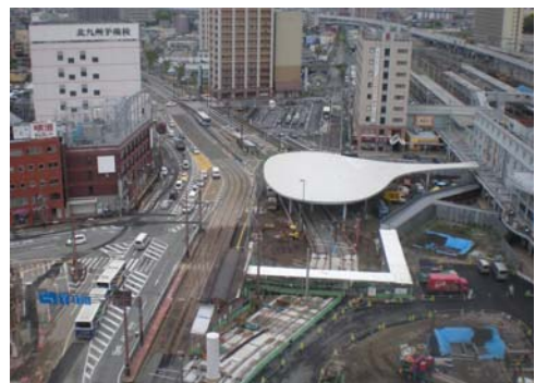
【JR熊本駅東口広場(市電電停の大屋根)】
