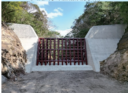
砂防堰堤の整備 （大淀川水系直轄砂防事業）
