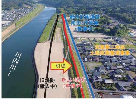
流下断面拡大のための堤防（引堤）を整備 （川内川河川改修事業）
