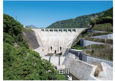
治水ダムの整備（R6.2完成） （立野ダム建設事業）
