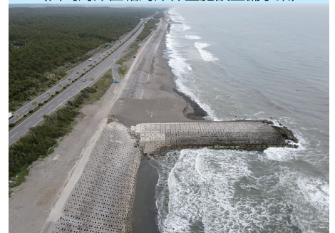
突堤の整備 （宮崎海岸直轄海岸保全施設整備事業）
