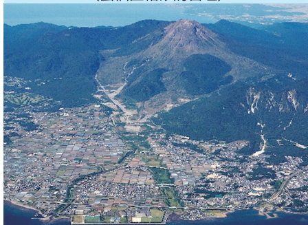
砂防施設の管理 （雲仙直轄砂防管理）
