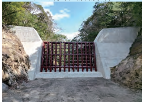
砂防堰堤の整備 （大淀川水系直轄砂防事業）
