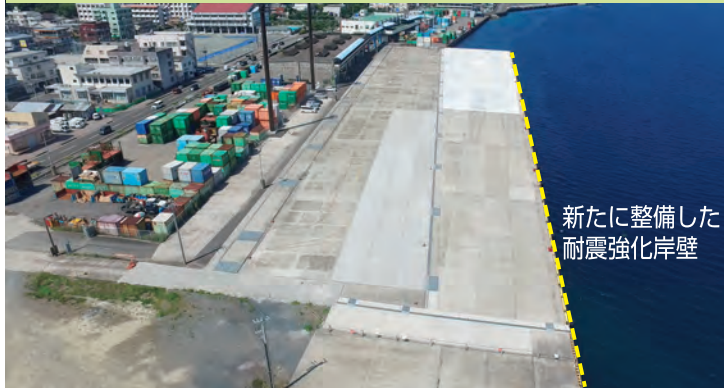
耐震強化岸壁の整備(名瀬港)
