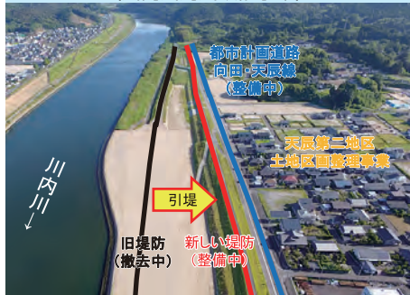
流下断面拡大のための堤防（引堤）を整備 （川内川河川改修事業）
