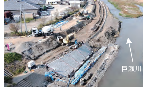
筑後川水系巨瀬川の整備状況
