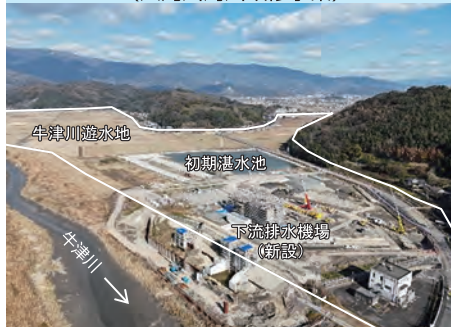
治水安全度向上のための遊水地整備 （六角川河川改修事業）
