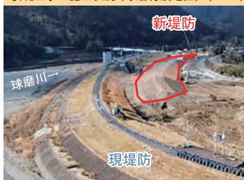
引堤工事の施工状況(球磨村渡地区)(R7.2)
