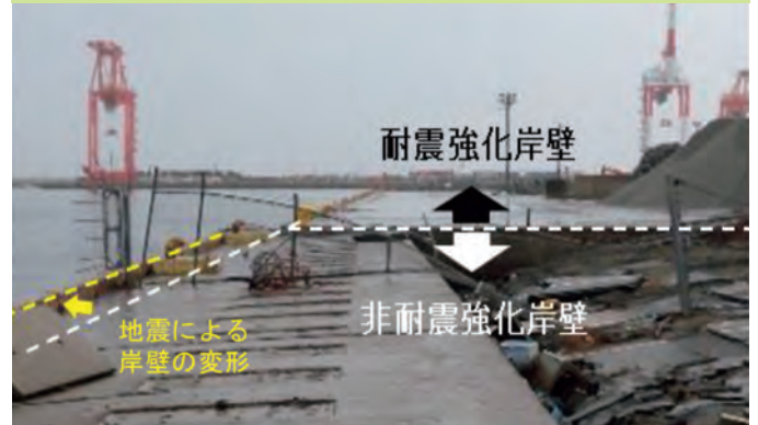
耐震強化岸壁と通常の岸壁の比較(仙台塩釜港)
