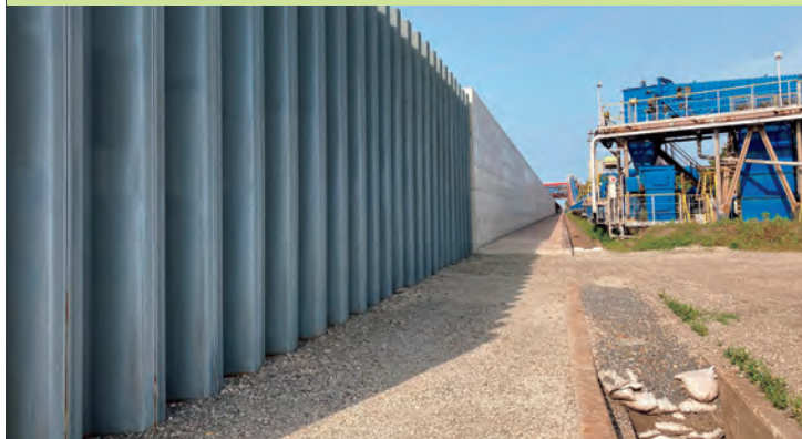
護岸整備状況(大分港海岸)
