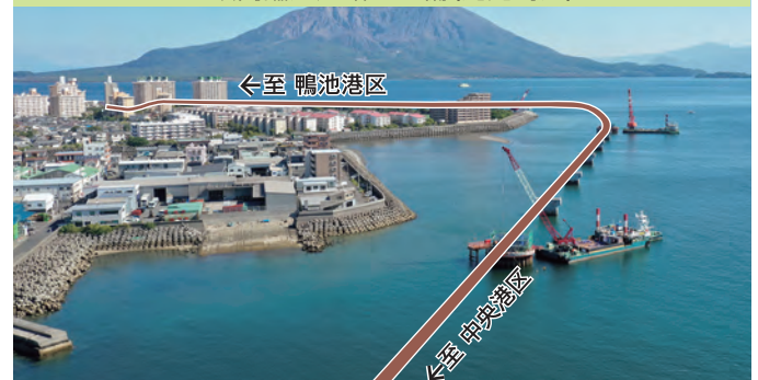
港湾物流のボトルネック解消のためのふ頭間臨港道路の整備(鹿児島港)
