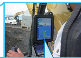
3次元データを重機に読み込み、 確認しながら目印（丁張り）無しで 効率的に工事を行います
