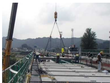
プレキャスト床版による 打ち替え
