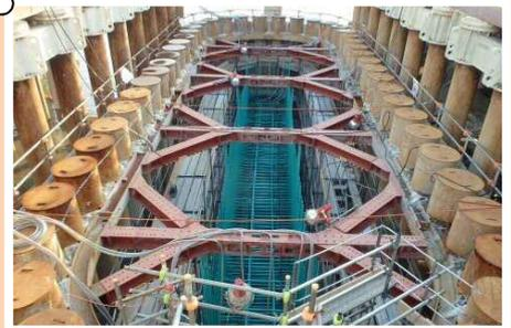
浦島橋は海水（塩水）の影響を受けるため、鉄筋へのさび対策がとても重要です。そこで鉄筋に『エポキシ樹脂』（みどり色）を塗り対策を行っています。
