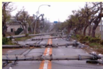
（電柱の倒壊による道路閉鎖）
