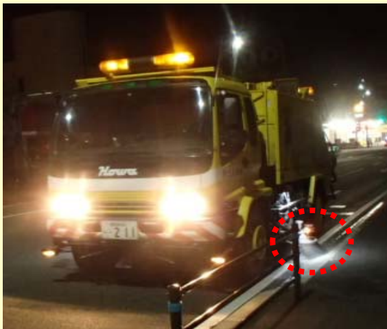
夜間の清掃作業の様子 【路面清掃車】
