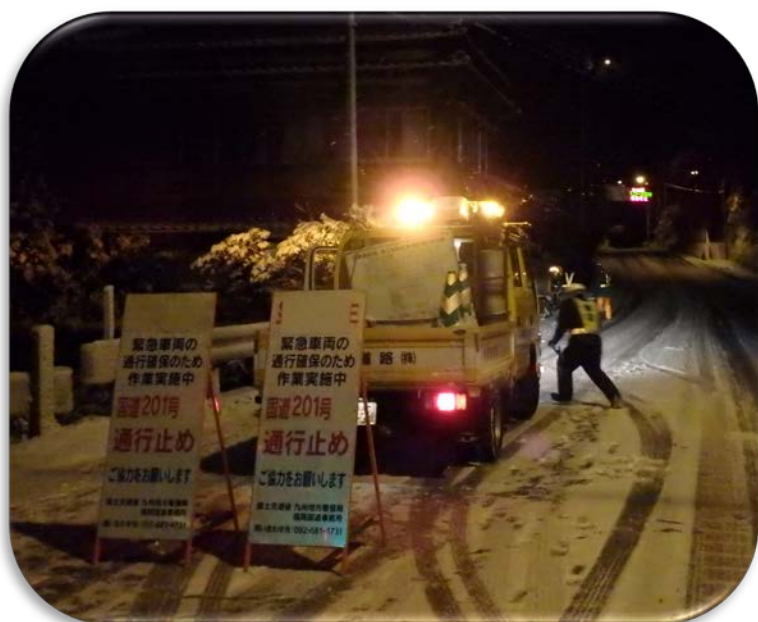
八木山峠通行止めの様子 (H28.1)
