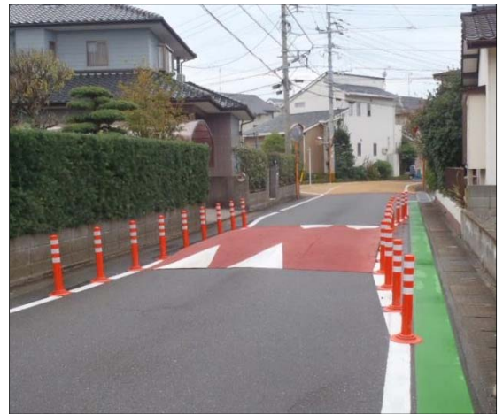
糟屋郡新宮町緑ヶ浜地区 （平成 28 年 11 月実証実験）
