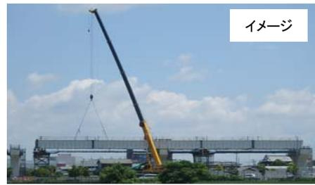
クレーン架設では、仮橋が必要となり、多数の仮橋用橋脚や橋梁を支える、ベントが川の流れを阻害。
