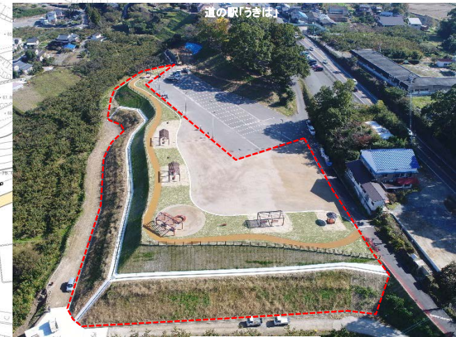
整備完成写真
