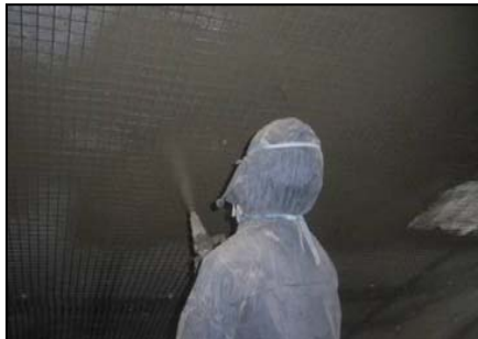
▲ 大規模修繕事業 補修状況
