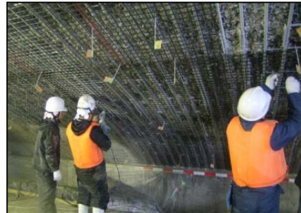
▲ 大規模修繕事業 補修状況
