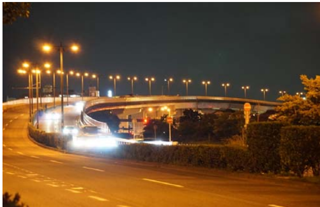
現在の関屋高架橋の状況
