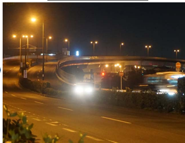
減灯中の関屋高架橋の状況
