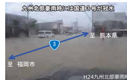
▲ 国道3号吉田交差点付近の冠水状況
