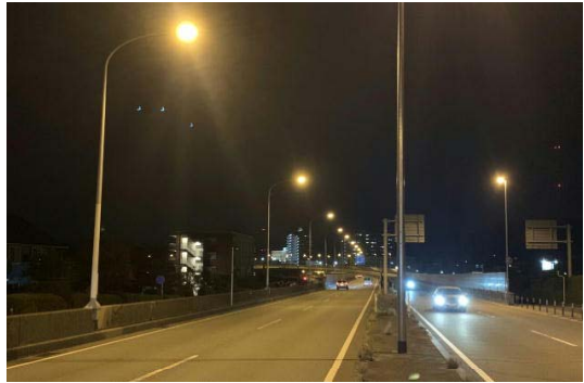
現在の筑紫野高架橋の状況
