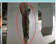
春吉橋は、損傷が著しく塩害も進行しています。更に 基礎が木杭であるため地震に対する耐力が期待でき ませんが、架替により耐震性が向上します。
