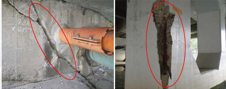
春吉橋は、損傷が著しく塩害も進行していました。更に基礎が木杭であるため地震に対する耐力が期待できませんが、架替により耐震性が向上します。
