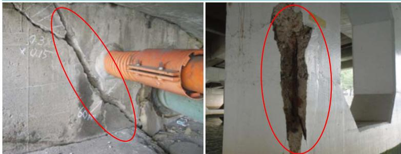
春吉橋は、損傷が著しく塩害も進行していました。橋の基礎を木杭から鉄筋コンクリート杭にする事で耐震性が向上します。
