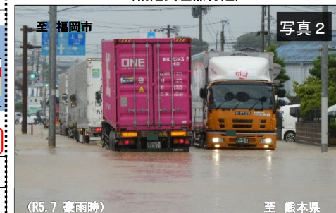
▲国道3号現道の冠水状況 (吉里橋交差点付近)
