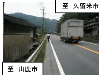
【整備前状況写真】
