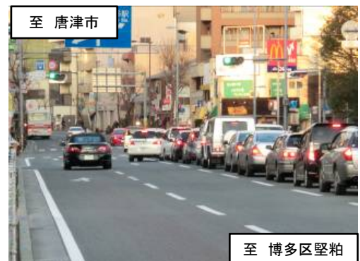
【整備前状況写真】
