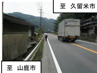
【整備前状況写真】
