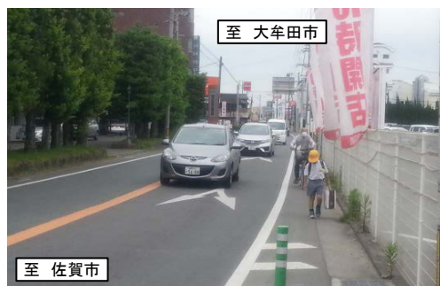
【整備前状況写真】
