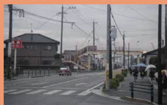
国道 209 号 井出の上自歩道設置（みやま市）
