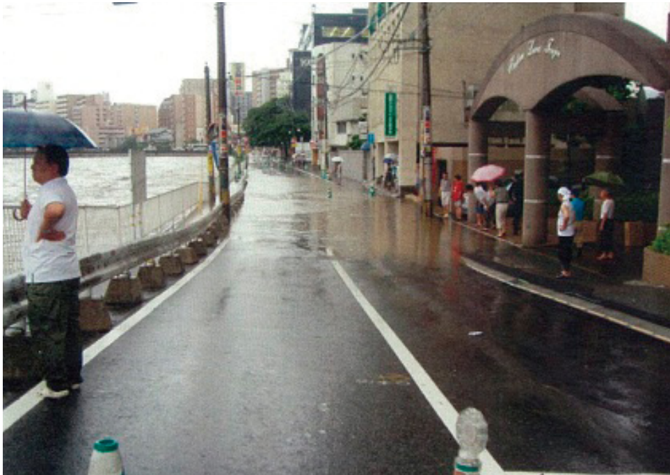
春吉橋周辺の道路の冠水状況（平成21年7月26日） （住吉橋左岸より上流側を望む）
