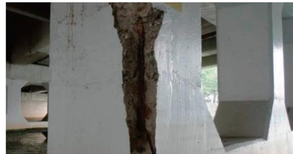
旧春吉橋の損傷状況 コンクリート剥離・鉄筋露出
