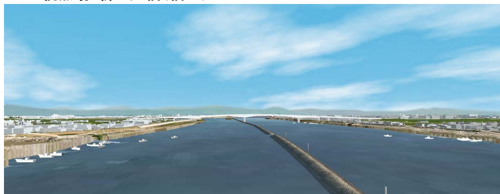
視点場:新田大橋(橋上)
