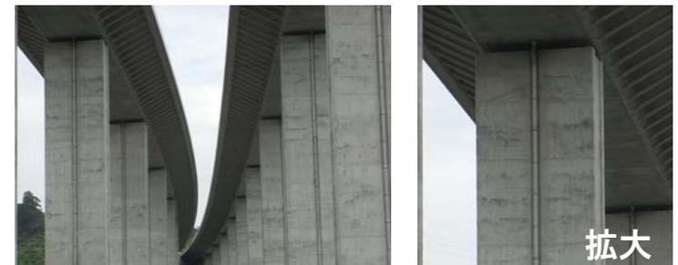
排水管を橋脚スリットに納めた例
