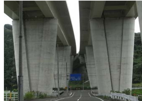
橋脚の面取りによる 圧迫感軽減の例
