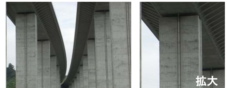
排水管を橋脚スリットに納めた例
