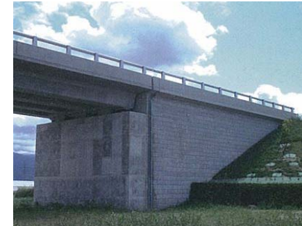
橋台のコンパクト化や 地覆ライン延長の例
