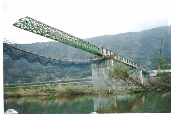
送り出し工法
