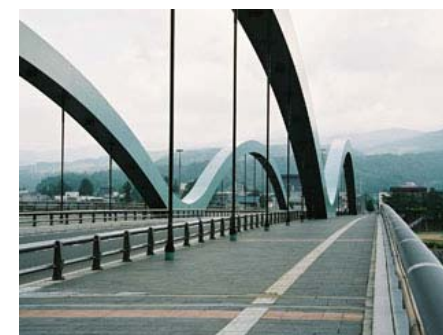
アーチリブの溶接事例
