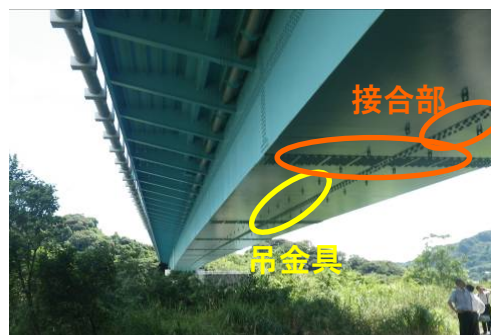
桁のボルト事例
