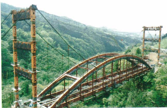
ケーブルエレクション工法
