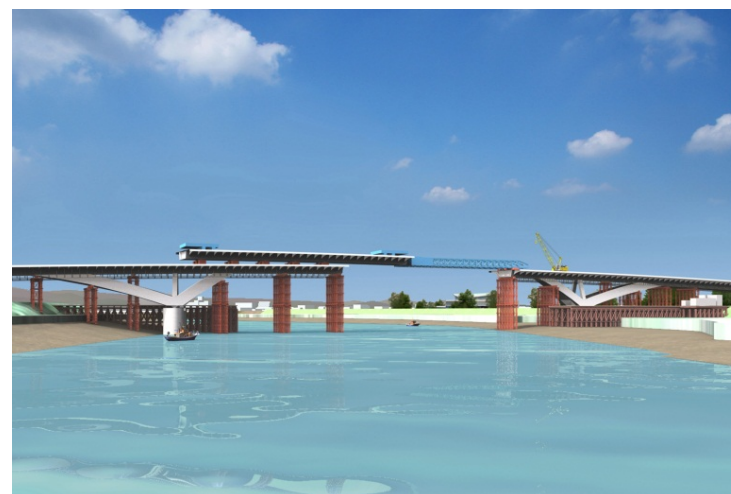
<支間部の送り出し架設>
