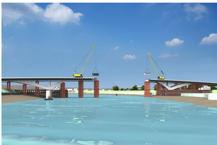
<補剛桁部のクローラクレーン，ベント架設>
