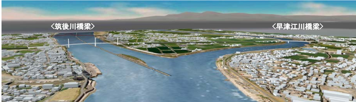
鋼斜張橋＋鋼床版箱桁橋
