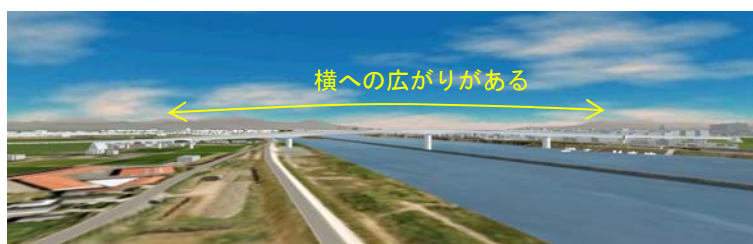
鋼床版箱桁橋（筑後川橋梁）
