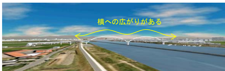
鋼アーチ橋（筑後川橋梁）
