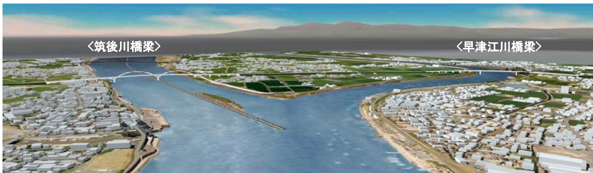
鋼アーチ橋＋鋼床版箱桁橋
