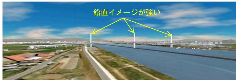
鋼斜張橋（筑後川橋梁）
