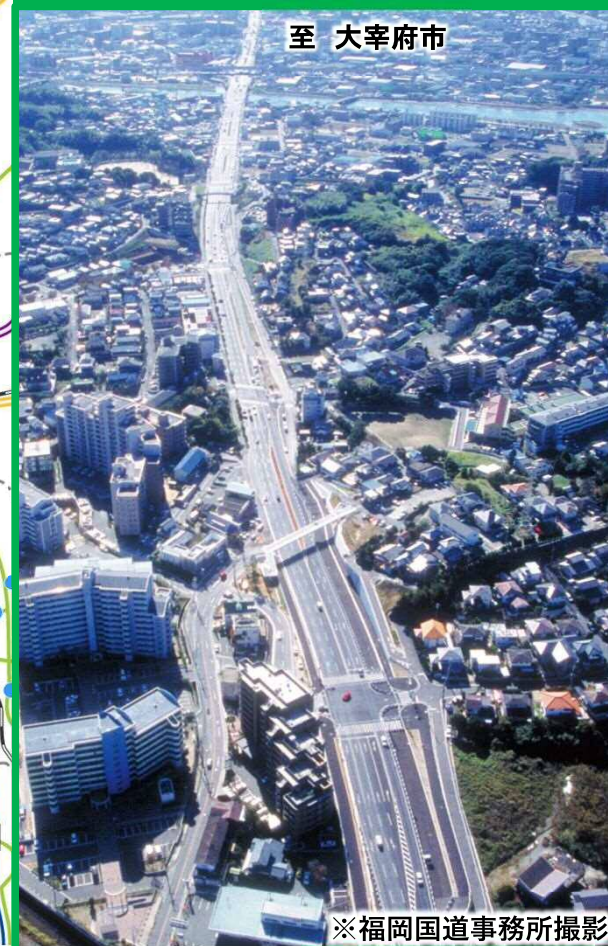
国道3号博多バイパス
