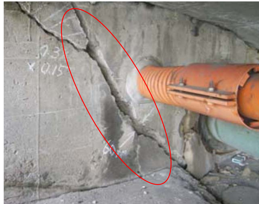
橋台のひびわれ
