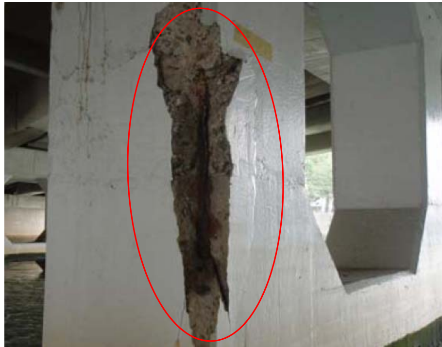
コンクリート剥離・鉄筋露出
