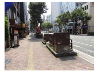
歩道内に設置された地上機器
