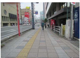
大きく傾斜した歩道
