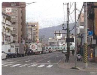
■連続立体交差事業（白木原駅北側） 現況
