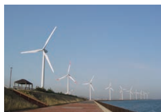
響灘風力発電所
