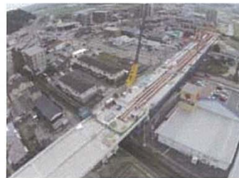
■基幹となる道路の整備事例 （主要地方道 筑紫野古賀線）
