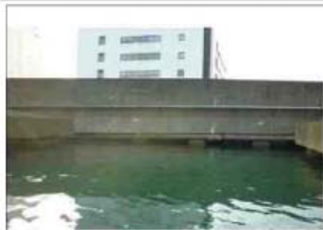
海水面に最も近接している箇所(大井埠頭橋付近) ※1日のうち2~3時間しか点検・補修ができない
