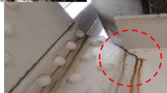
主桁(横桁)の損傷(亀裂)
