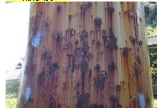
補強鋼板の腐食
