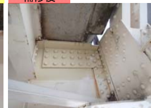
損傷(亀裂)箇所の補強
