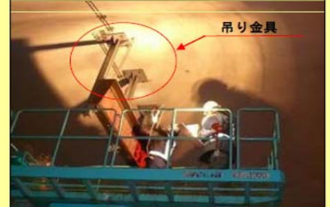
【トンネル内附属物（照明等）の点検②】
