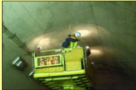
【近接目視によるひび割れ探査②】
