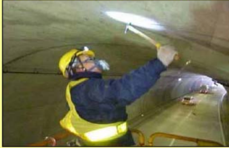
【ハンマーによる打音検査②】
