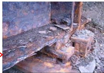
死角となっている箇所
