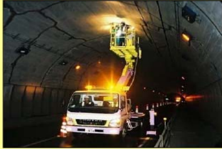
【近接目視によるひび割れ探査②】
