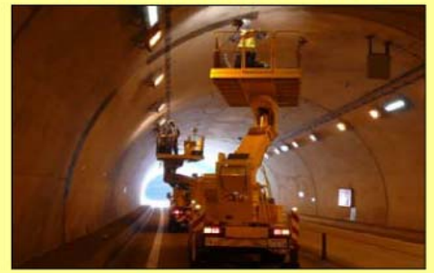
【トンネル内附属物（照明等）の点検②】
