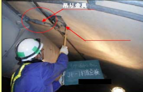
【ハンマーによる打音検査②】
