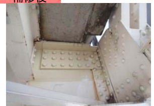
損傷(亀裂)箇所の補強
