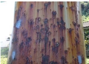
補強鋼板の腐食
