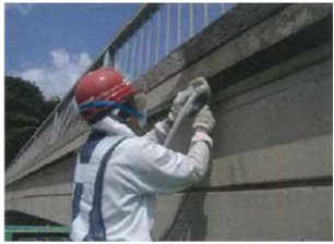
補修実施状況
