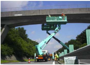
点検実施状況
