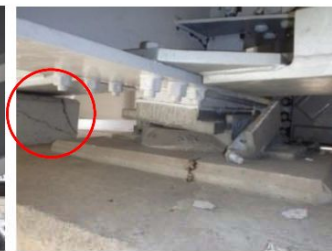
写真-6 支承の破損の状況
