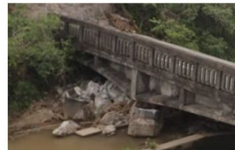
写真-2 平田・小柳線 田中橋
