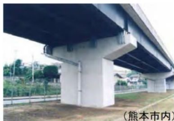
写真-3 国道3号 跨線部
