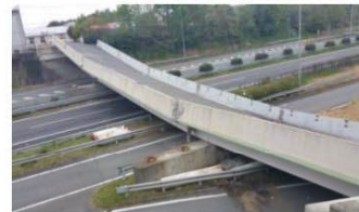
写真-1 県道小川嘉島線 府領第一橋
