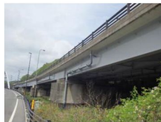
写真-4 阿蘇口大橋 (国道57号)
