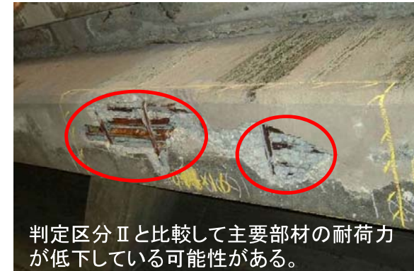
判定区分Ⅲ(主桁の断面欠損)
