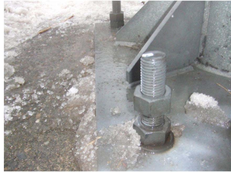
ボルトの緩み (施工不良)
