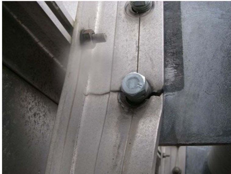
き裂損傷 (車両衝突)
