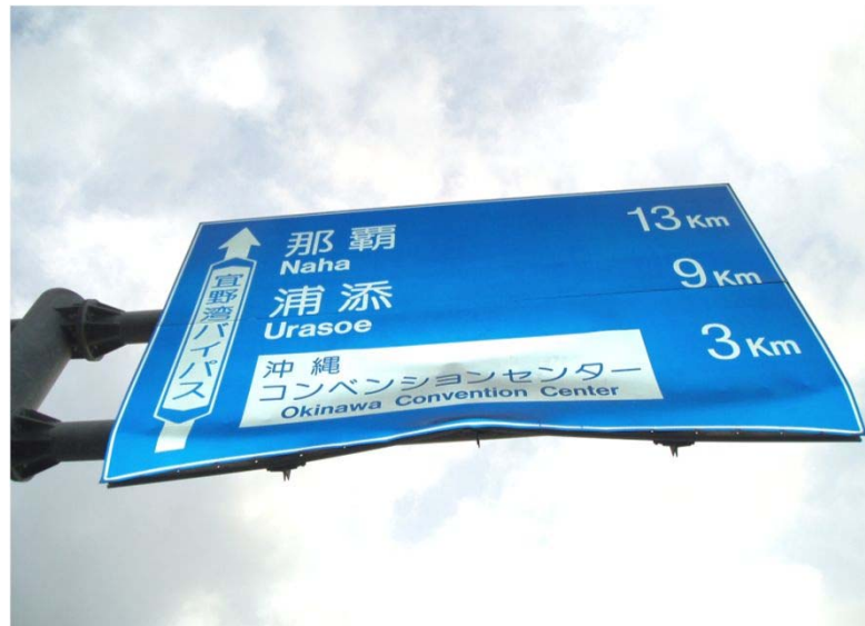
異常変形 (車両衝突)
