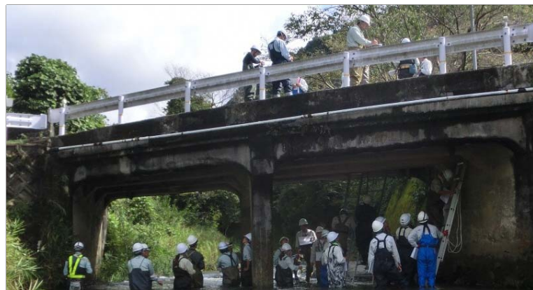
橋梁点検実務者研修(フィールドワーク)の状況
