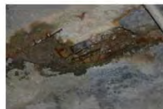
覆エコンクリートの剥落・貫通ひびわれ
