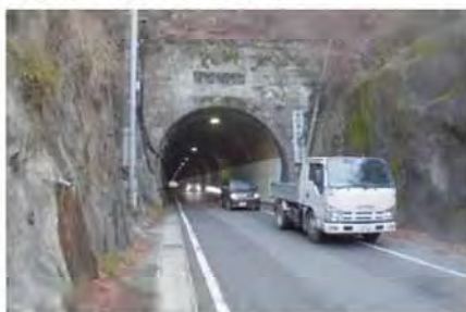
<仁方隧道の状況>
