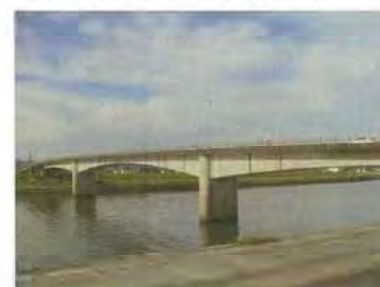
<天大橋の状況>
