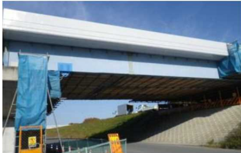
橋梁点検と補修工事で足場を共有
