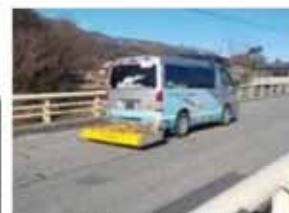
電磁波技術を利用した床版上面の損傷把握
