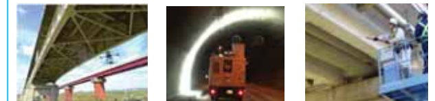
▲橋梁の損傷写真を撮影する技術 ▲トンネルの変状写真を撮影する技術 ▲コンクリートのうき・はく離を非破壊で検査する技術
