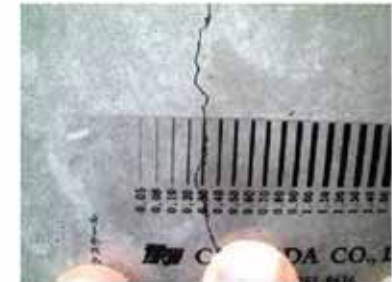
手作業による覆工ひび割れ幅の計測
