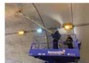
レーザーを利用したトンネル覆工の変状把握
