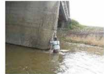
手作業による下部工洗掘削状況の計測
