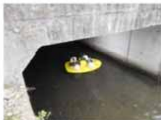
水上ドローンによる損傷把握
