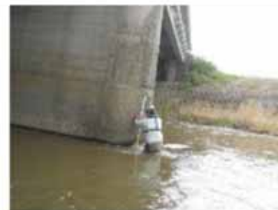
手作業による下部工洗掘状況の計測
