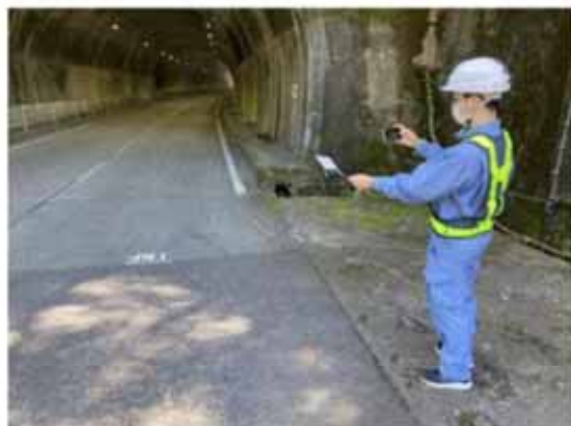
目視により路面性状を確認
