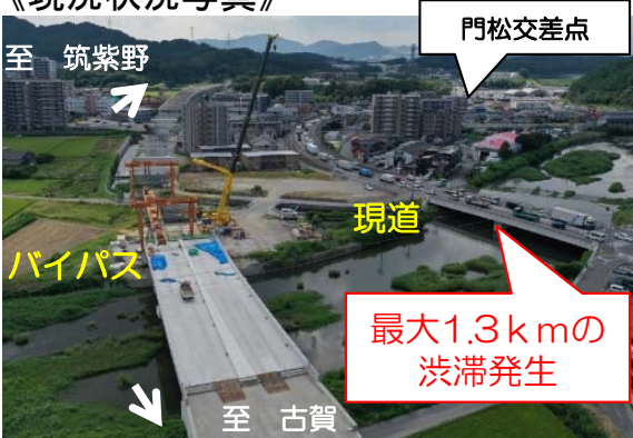
《現況状況写真》
