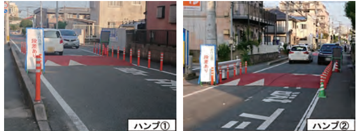
▲実証実験(可搬型ハンブを設置)(那珂川市)
