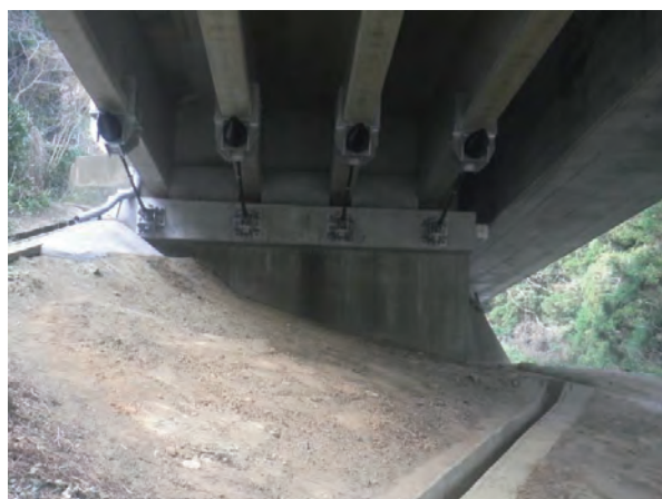
▲耐震補強(落橋防止)
