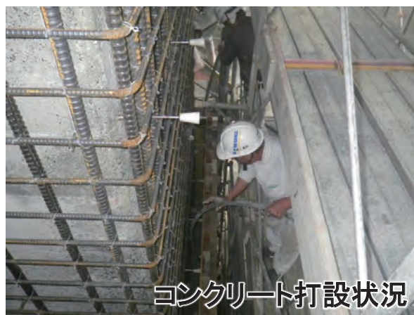
▲耐震補強(柱部コンクリート巻立)
