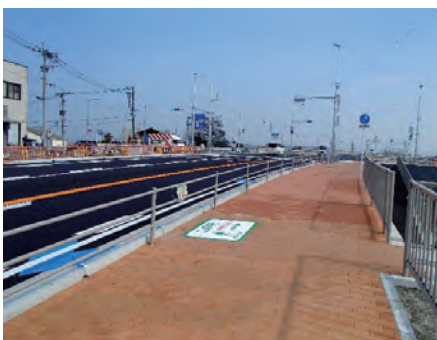
▲火山灰を加工したレンガによる透水性の確保
