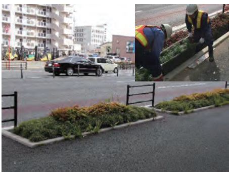
▲植栽ユニットによる施工性の向上
