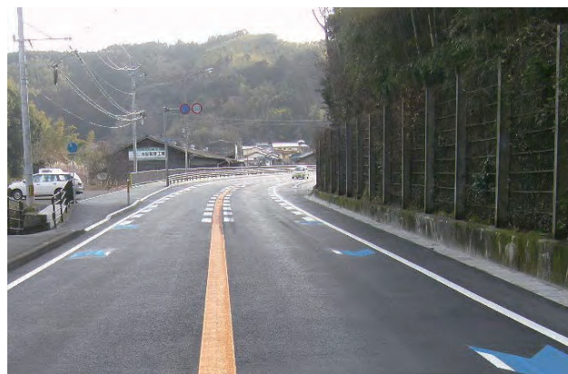
▲国道3号 下辺春地区(八女市)
