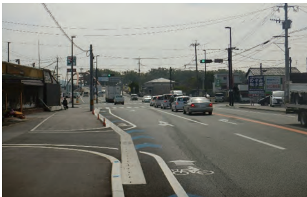
▲国道209号 尾島交差点(筑後市)
