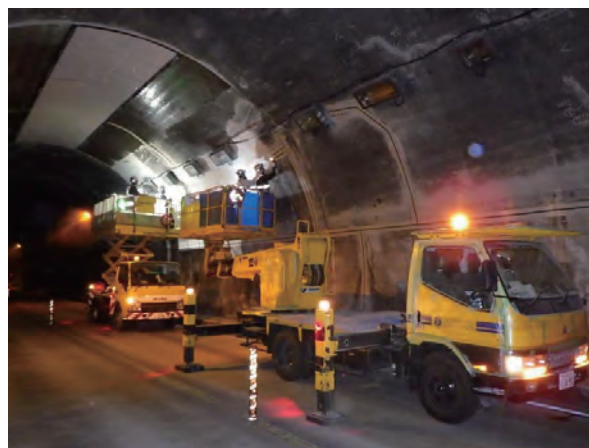
▲立花トンネル補修
