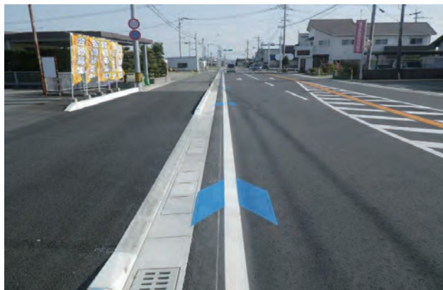
▲国道208号鷹ノ尾地区(柳川市)
