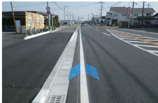
▲国道208号 鷹ノ尾地区(柳川市)
