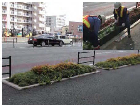
▲植栽ユニットによる施工性の向上
