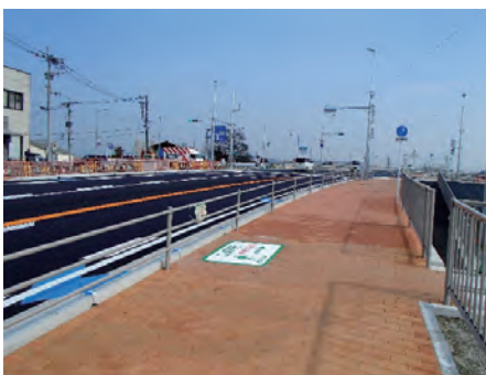
▲火山灰を加工したレンガによる透水性確保
