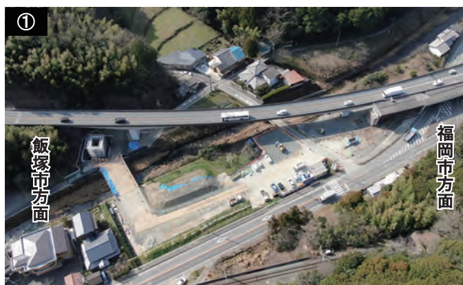
▲筑前山手橋 工事状況
