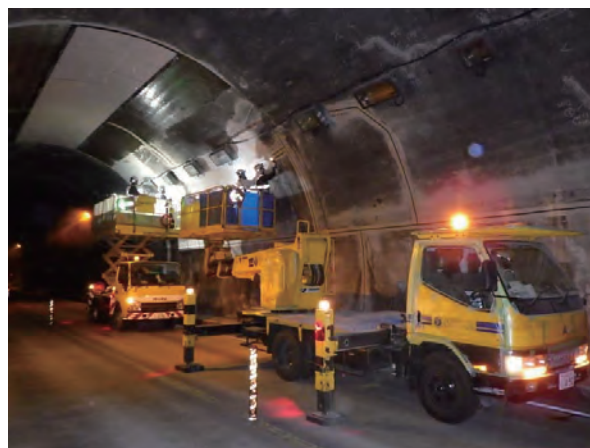
▲立花トンネル補修
