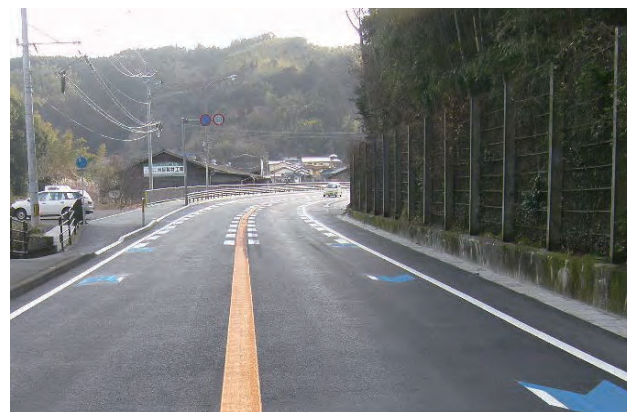
▲国道3号 下辺春地区(八女市)
