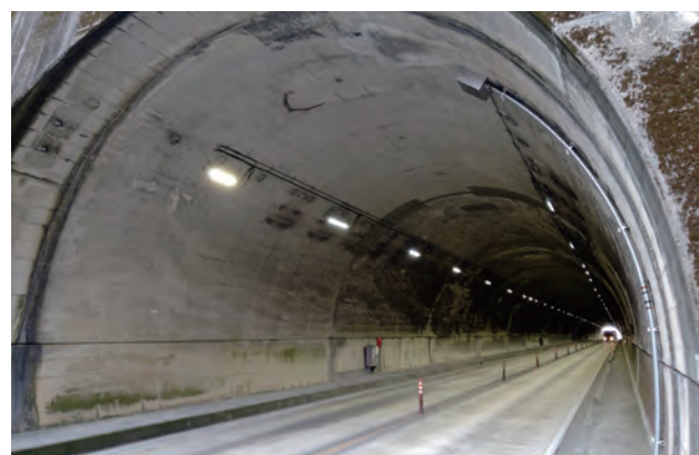
▲国道202号 甲ノ峯トンネル(糸島市)
