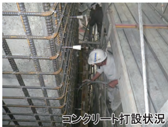
▲耐震補強(柱部コンクリート巻立)
